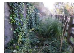
西側の入口が草で覆われている
